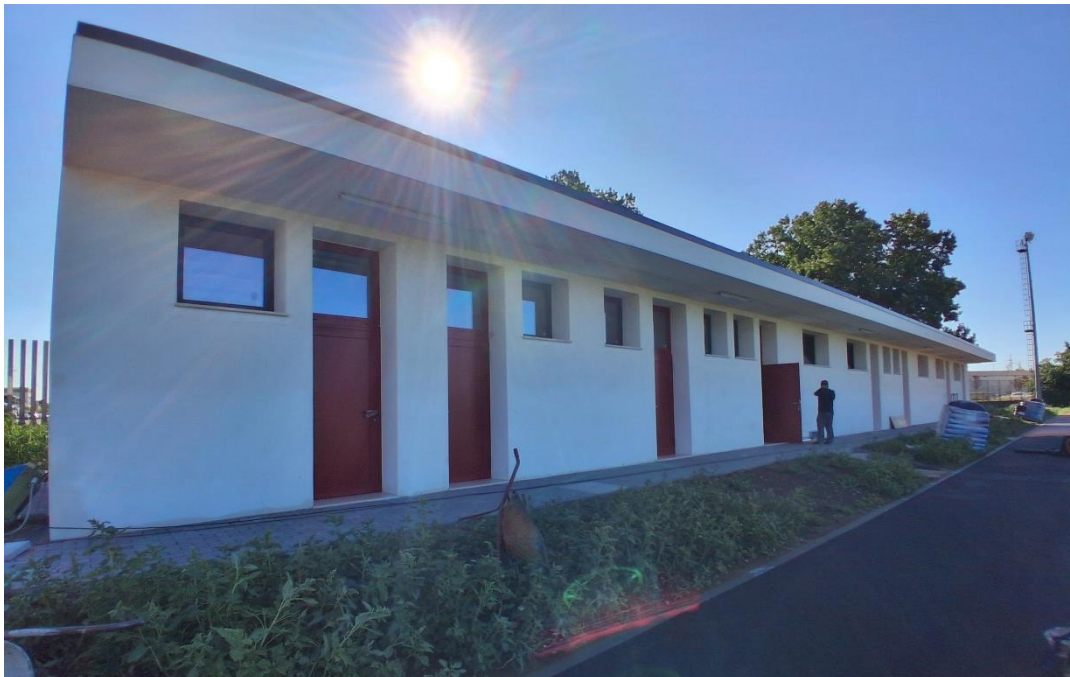
Foto dei nuovi spogliatoi
