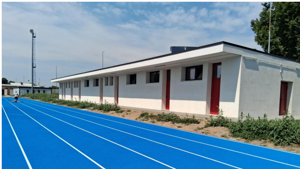
Foto dei nuovi spogliatoi
