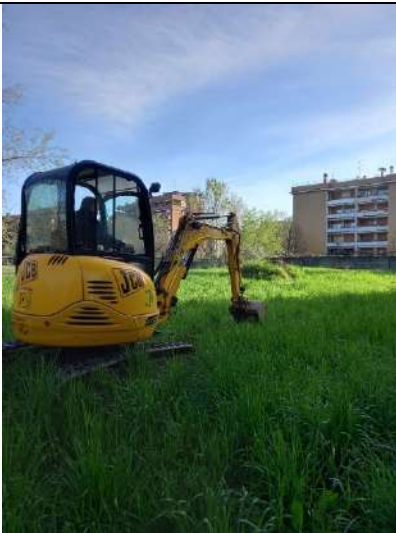
Postazione Trincea T1
