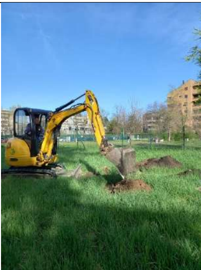
Postazione Trincea T2
