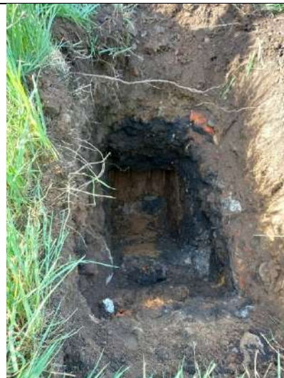
Scavo Trincea T2
