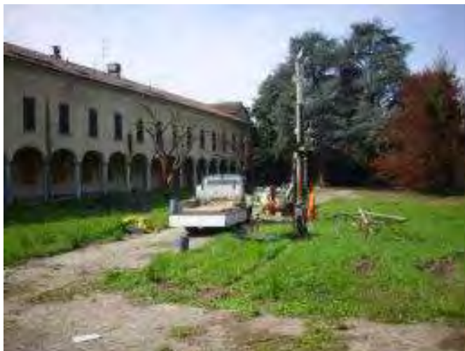
Foto 1: Esecuzione sondaggio S1
