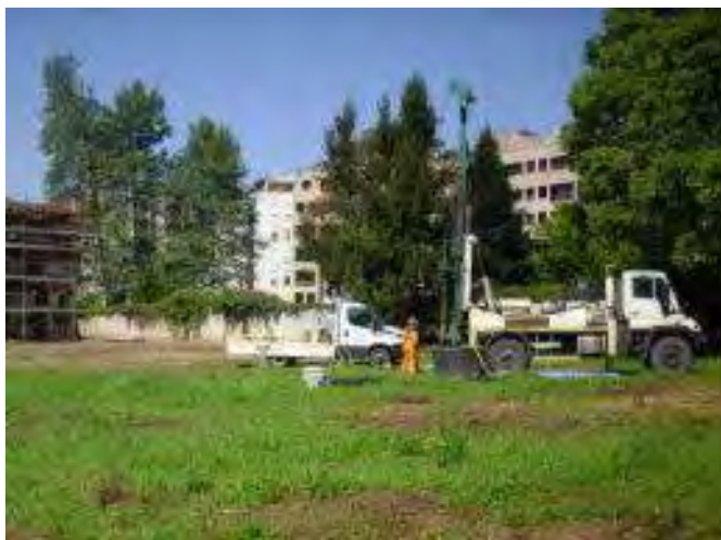
Foto 3: Esecuzione sondaggio S3
