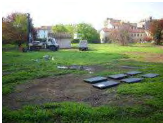
Foto 4: Esecuzione sondaggio S4
