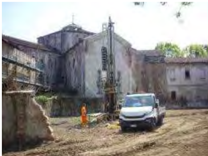
Foto 2: Esecuzione sondaggio S2
