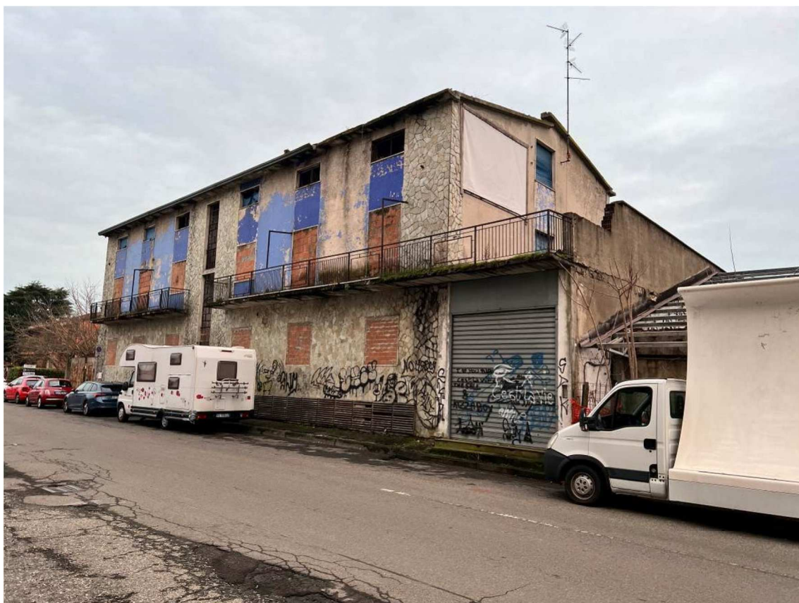
Edificio da demolire – Posizione microfono
