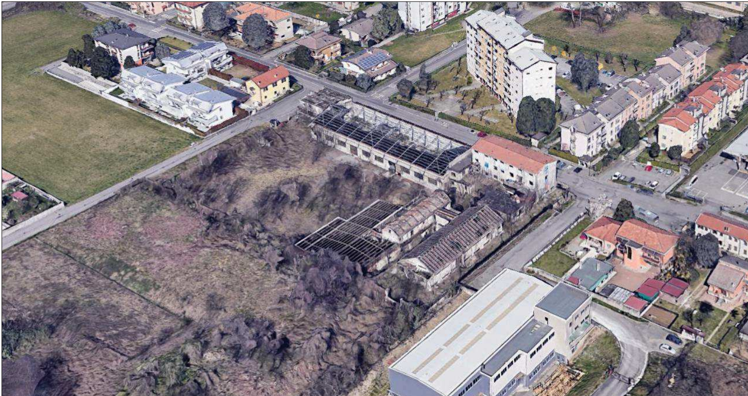
VISTA AEREA DA SUD-EST
