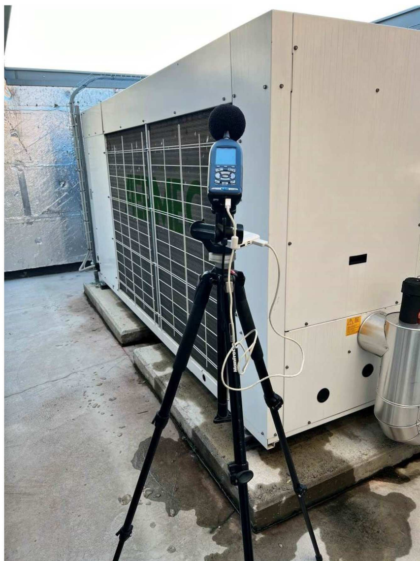
Misurazione impianti interno copertura
