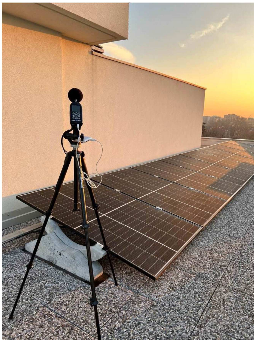
Misurazione impianti esterno copertura
