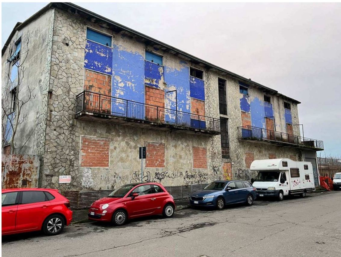
Edificio da demolire – Posizione microfono
