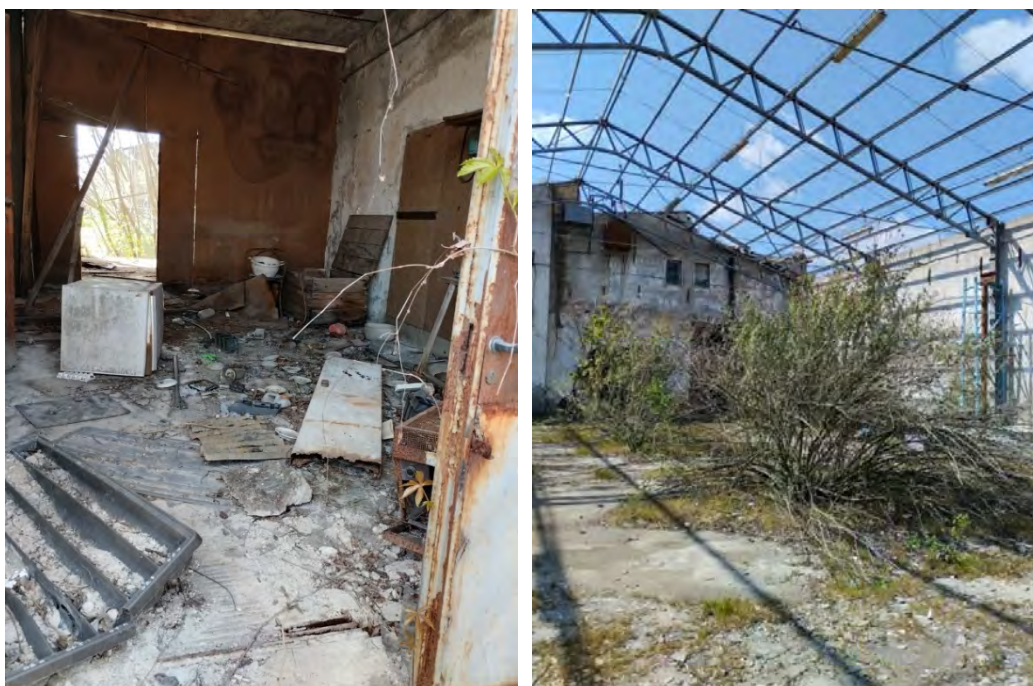
Figura 1 – Le condizioni in cui versano i fabbricati dell'area
