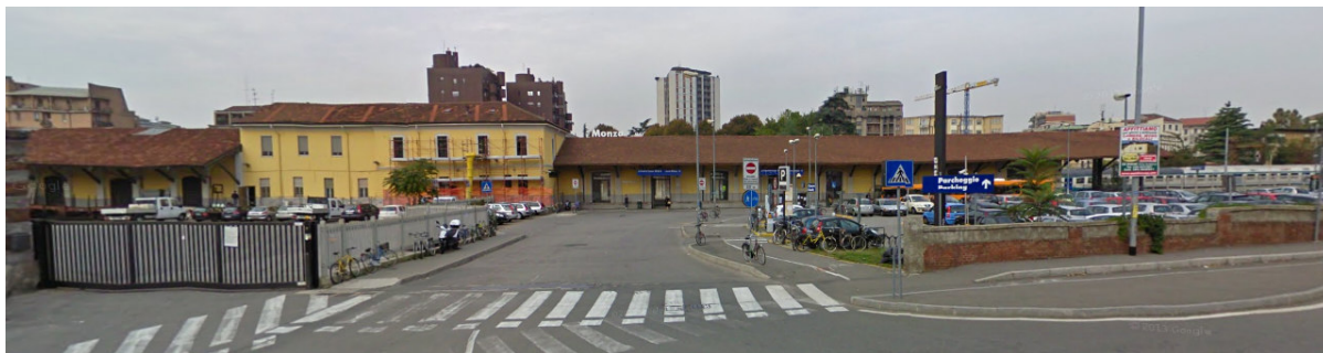
Foto 1 – Stazione ferroviaria di Monza – accesso lato binario 7
