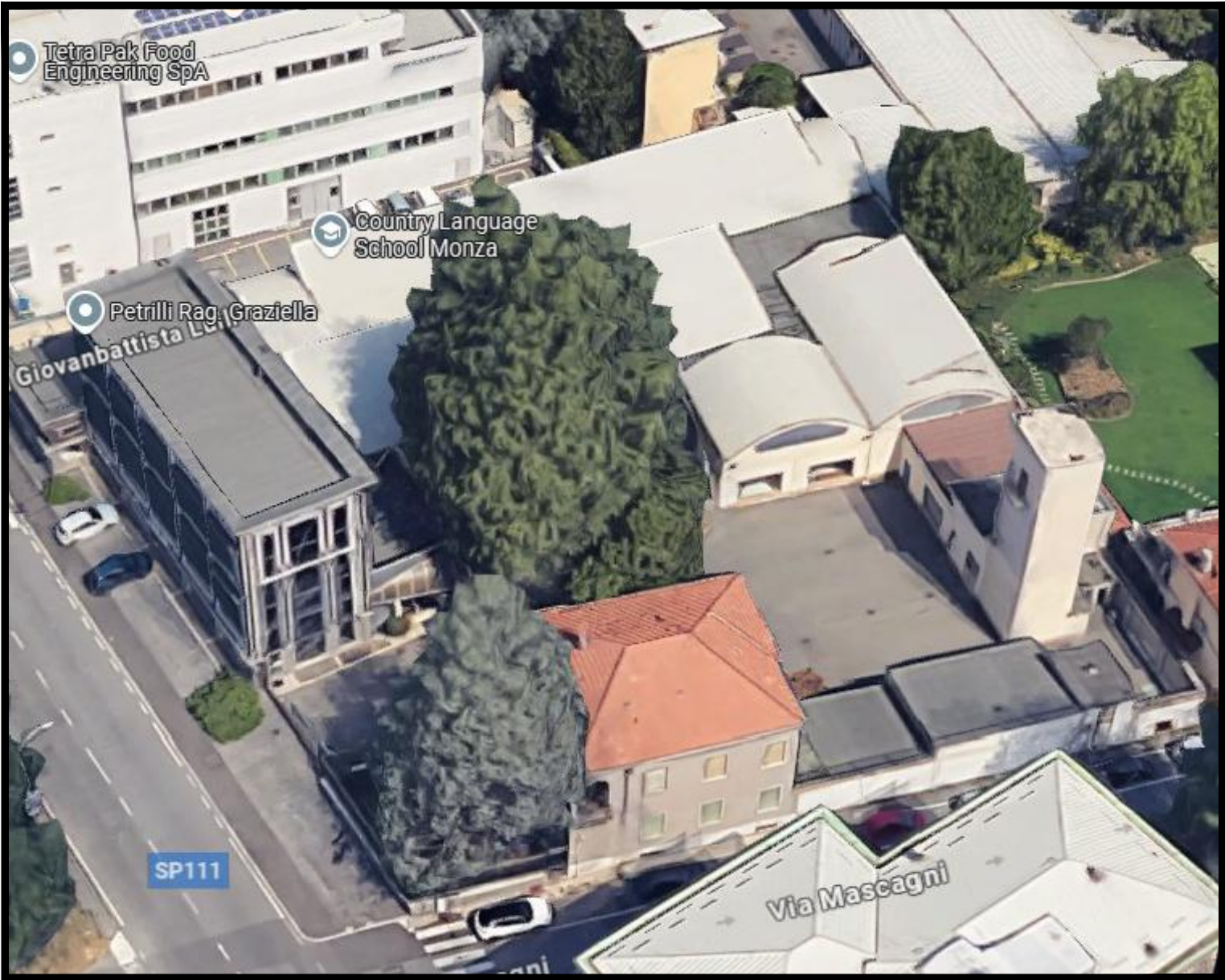
FOTO AEREA DA SUD
