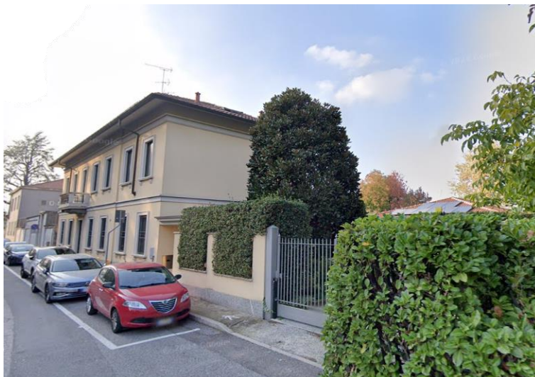
lato Sud, edificio residenziale
