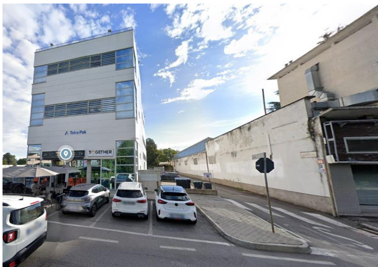
lato Nord-Ovest, via Lulli/via Boito
