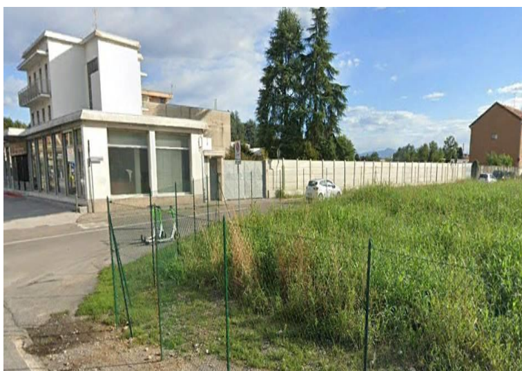
lato Nord, via Cadore/via Boito
