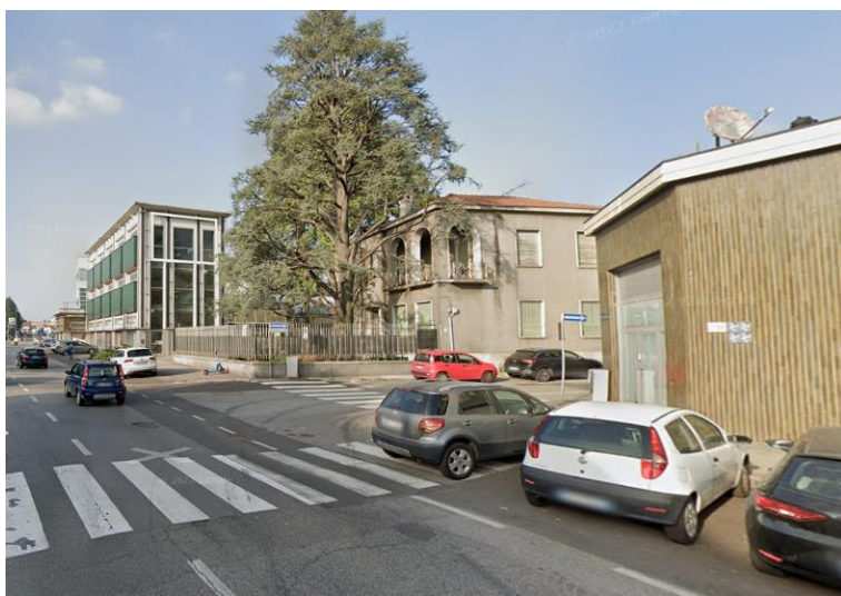
lato Ovest, via Boito
