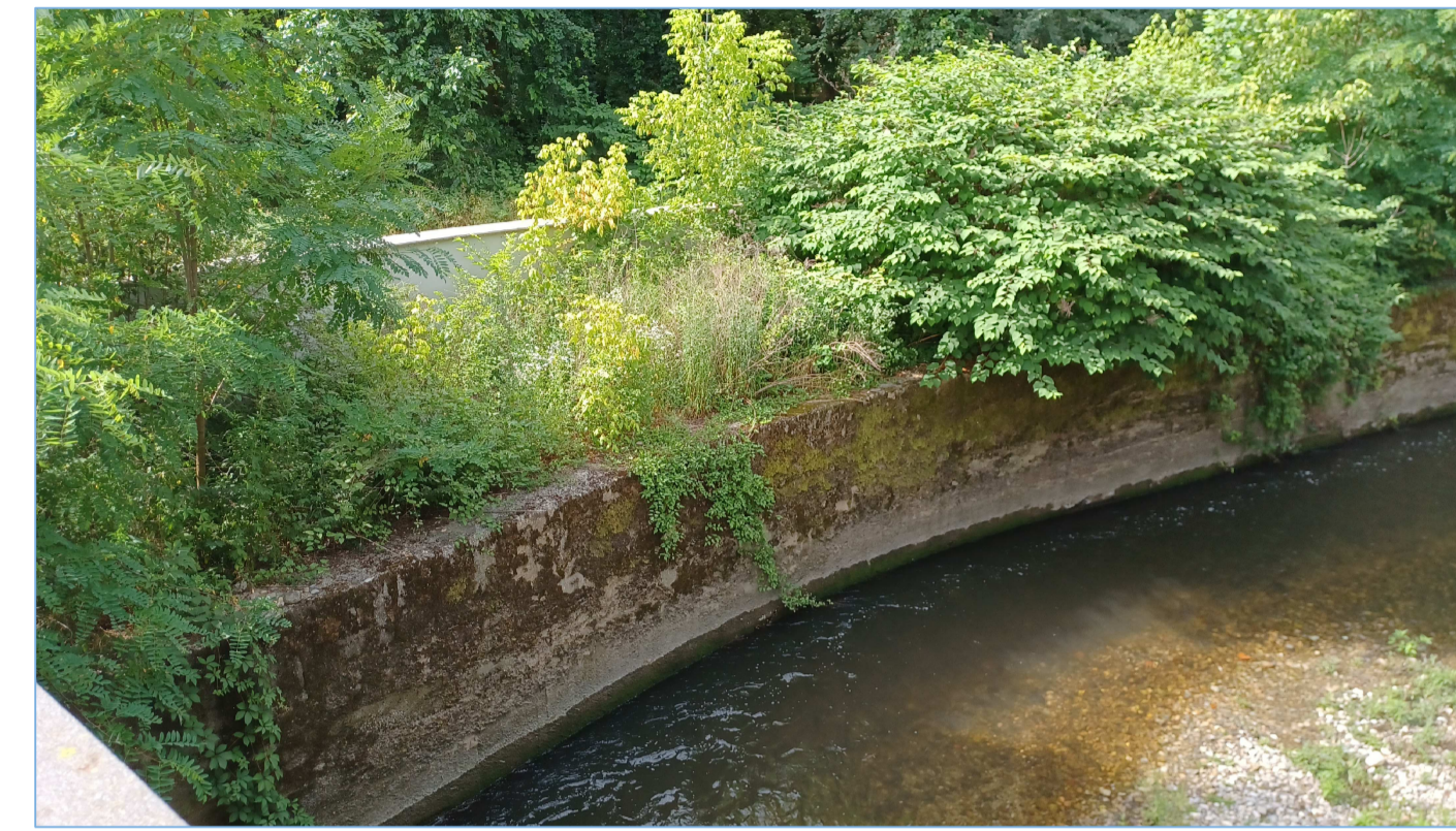
ARGINI E FASCIA DI MANUTENZIONE
