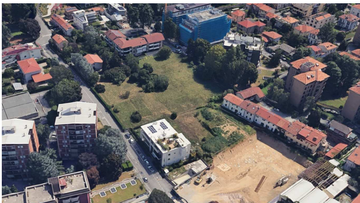
Vista aerea dell'area di intervento
