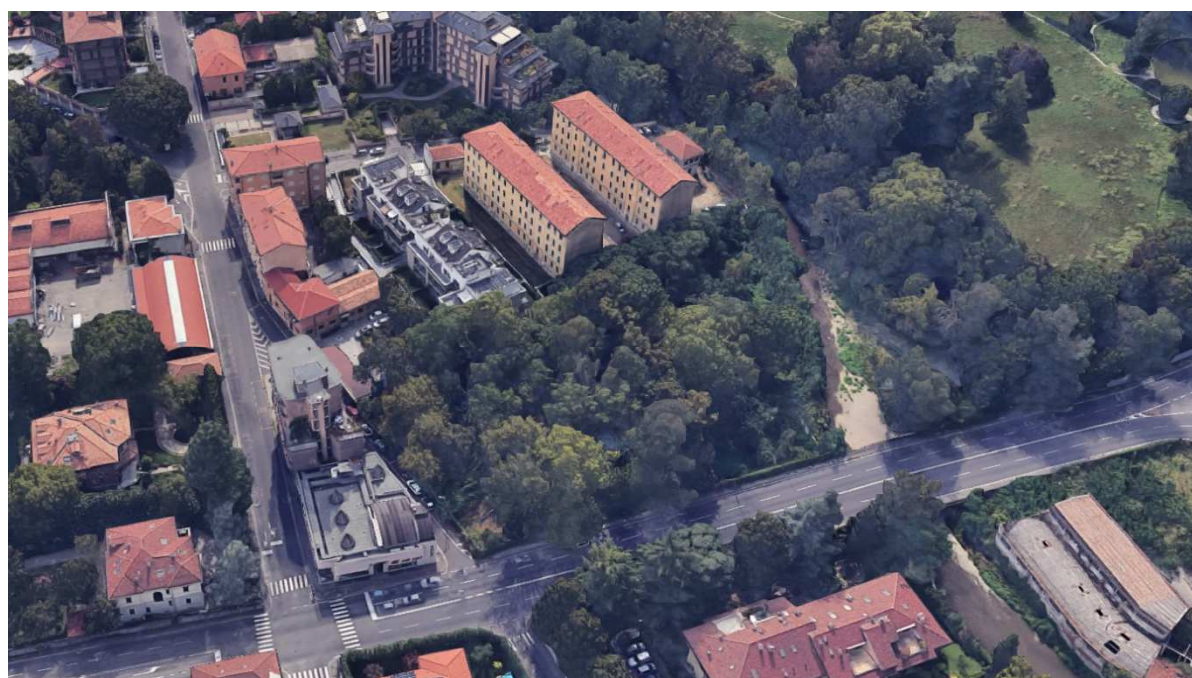
Vista aerea dell'area di intervento
