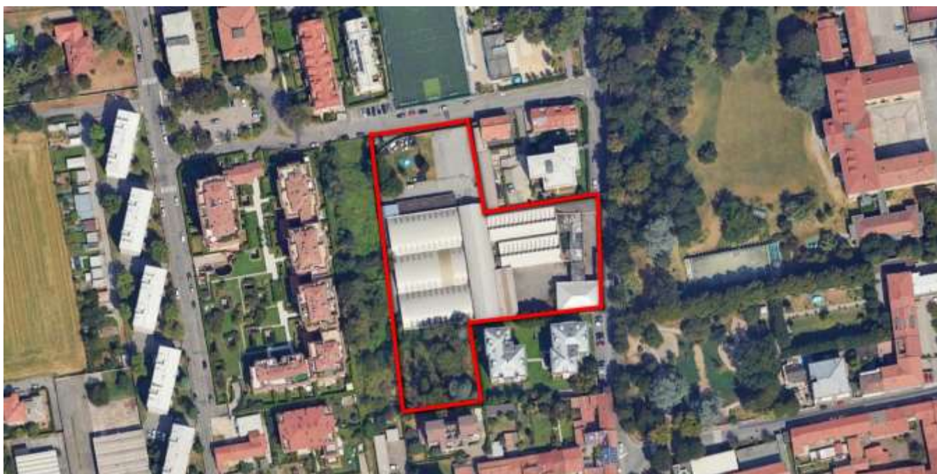
Foto aerea area in esame
