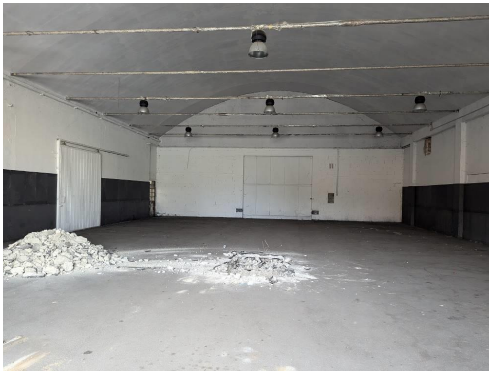
Interno capannoni (ingresso via Montanari)
