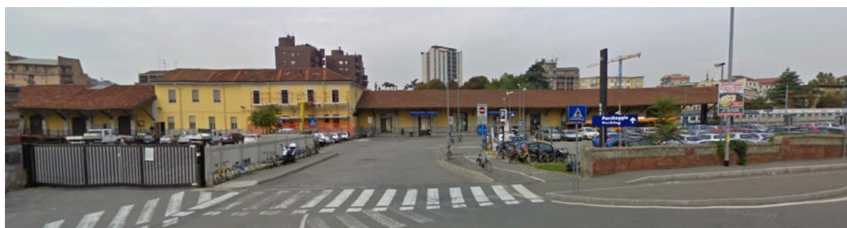
Foto 1 – Stazione ferroviaria di Monza – accesso lato binario 7
