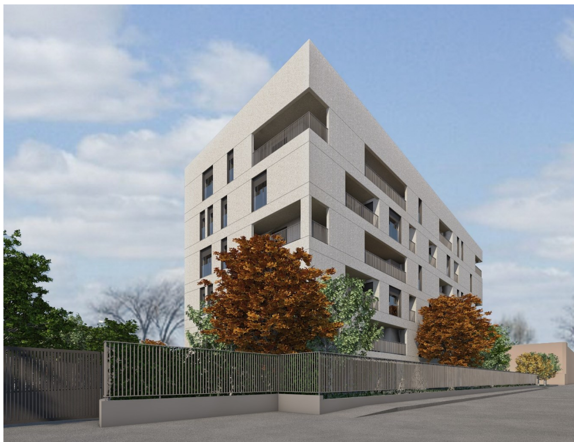
Vista da via monte Albenza
