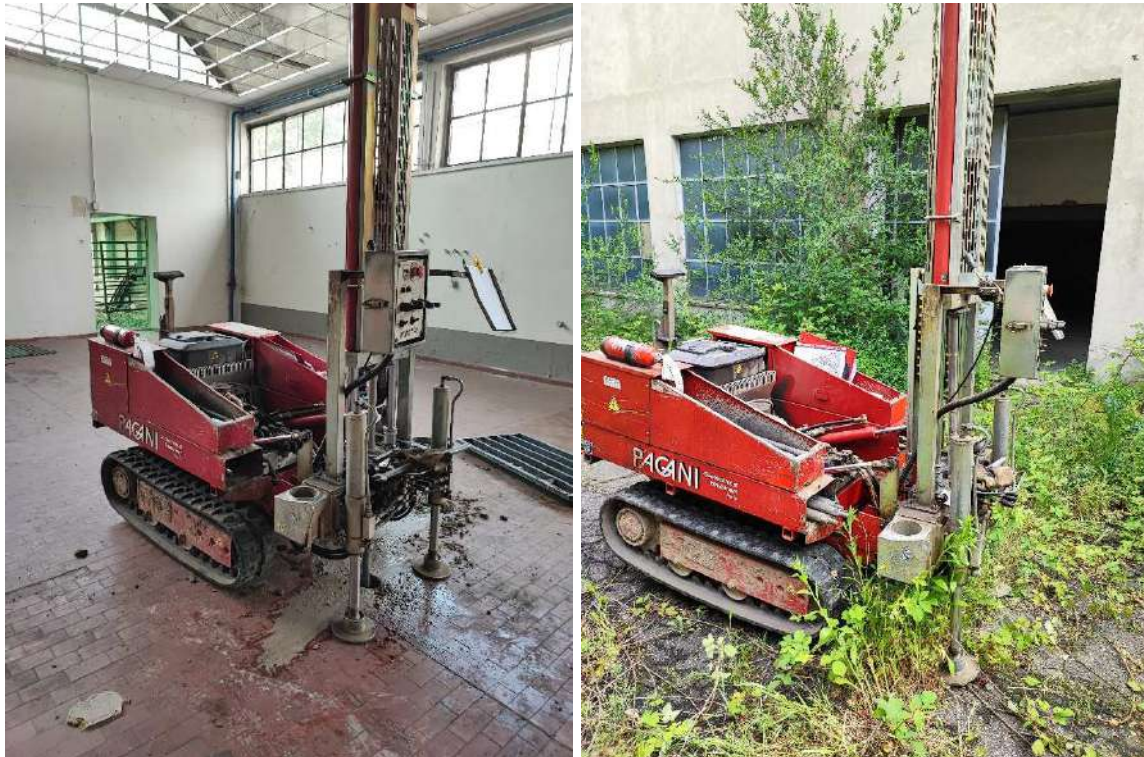
Esecuzione delle prove penetrometriche SCPT
