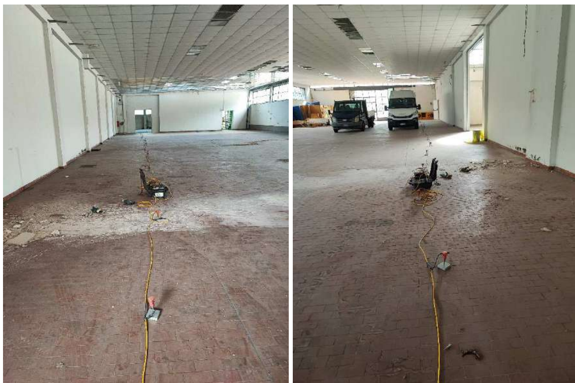
Esecuzione della prova sismica MASW
