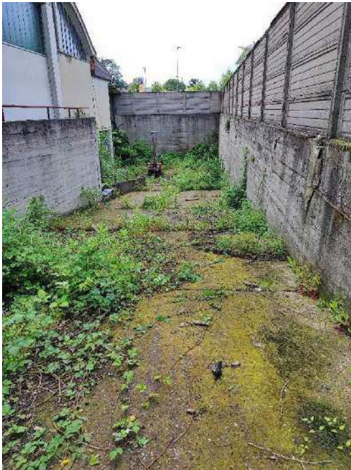
Rampa di accesso al piano interrato
