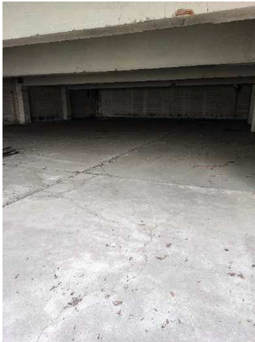
Interno piano interrato
