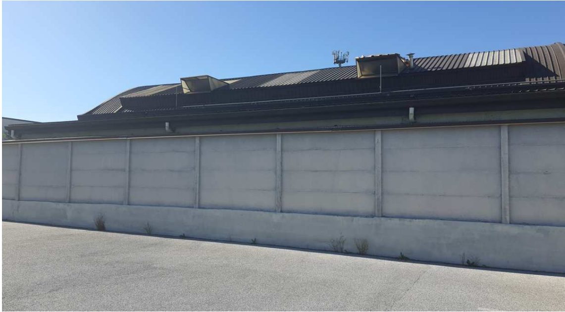
Foto n°8 – Il muro di cinta a separazione lungo il fronte Sud tra il parcheggio del supermercato e il futuro lotto residenziale
