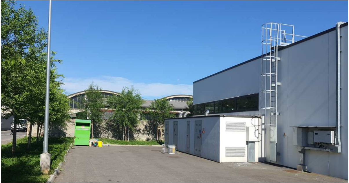
Foto n°6 – Le installazioni impiantistiche del supermercato a confine sul fronte Ovest del futuro edificio
