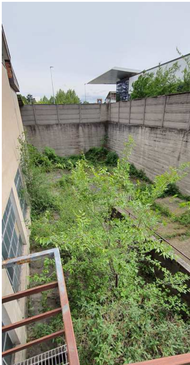
Foto n°2 – Fronte Est edificio esistente rivolto verso supermercato a confine
