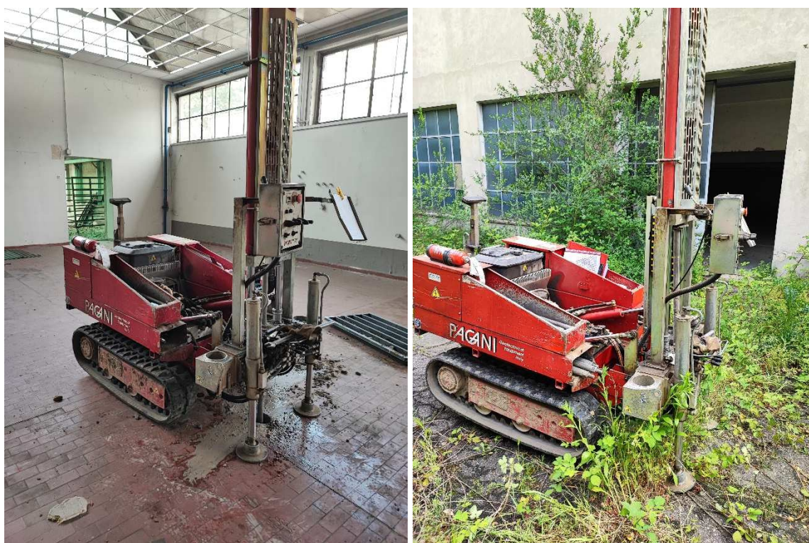
Esecuzione delle prove penetrometriche SCPT.
